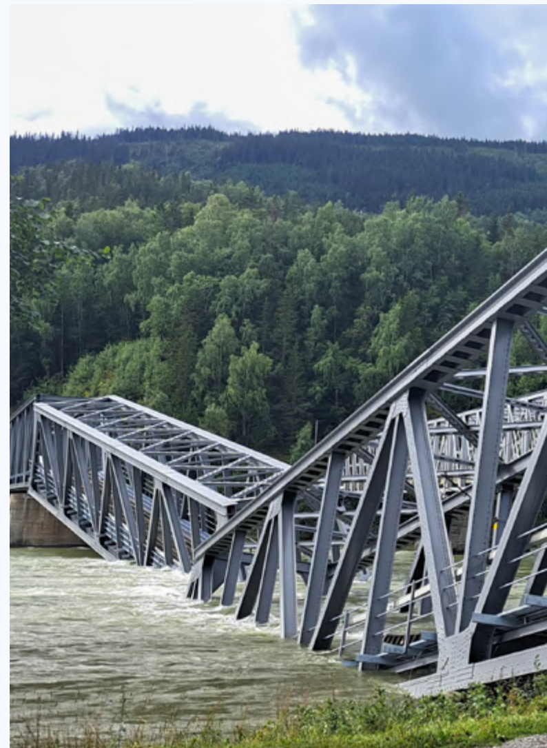
Brukollaps over Gudbrandsdalslågen i Ringeby. Foto: Lars Skjeggstad Kleven / NTB
