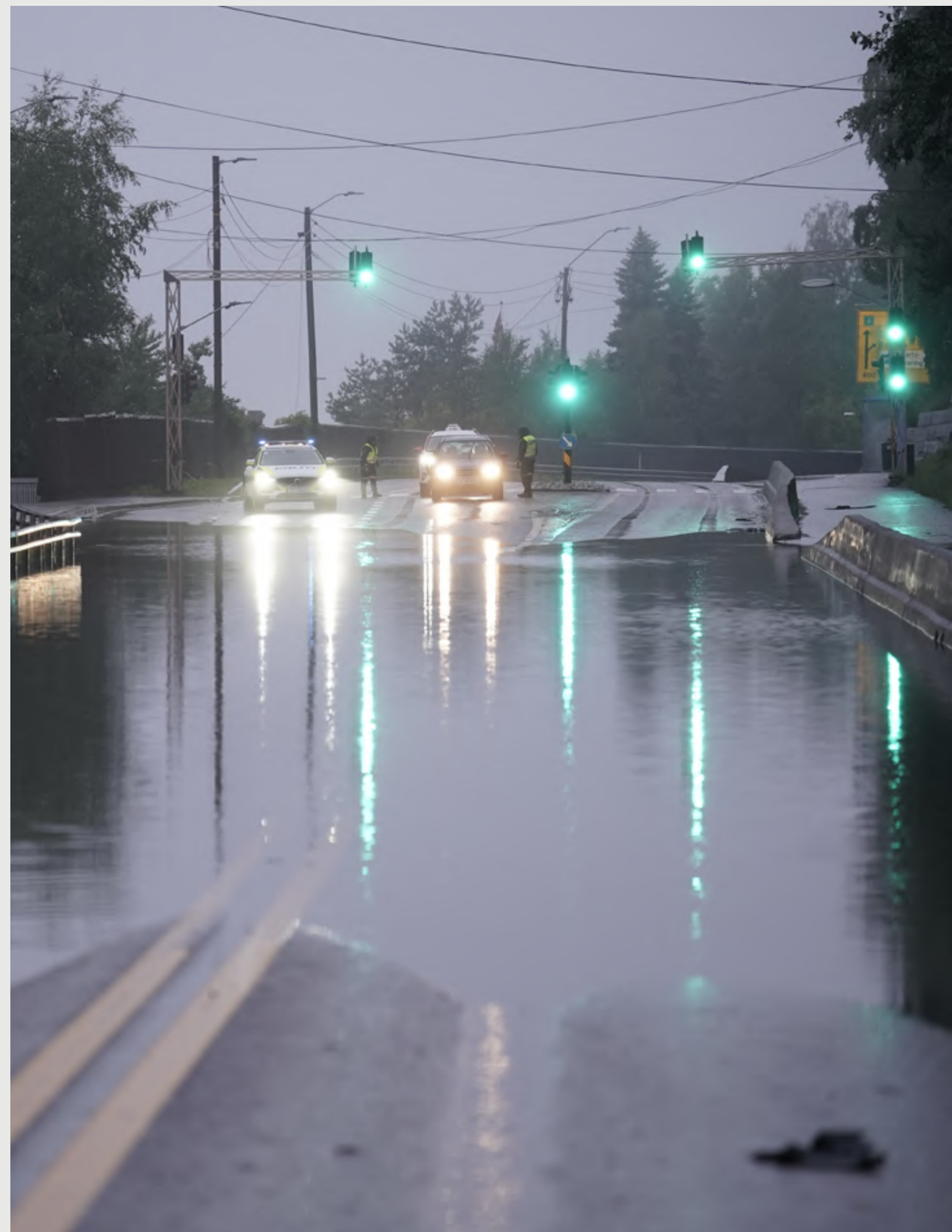
Kraftig nedbør i Oslo, riksvei 4. Foto: Stian Lysberg Solum / NTB
