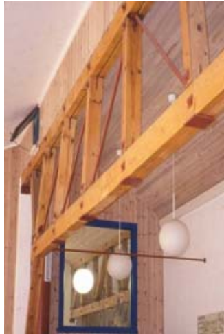
Fagverksbjelke av tre (Vanse skole). Limte forbindelser er erstattet med bolter av metall. Foto og arkitekt: GAIA Lista/ Berge.
