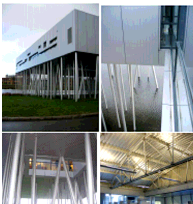
Bildet viser Aluminium Centre i Houten (arkitekt Micha de Haas). De fleste bygningsdeler i bygget er av aluminium. Ifølge arkitekten er de 100% dekomponerbare. (Foto: Nordby)
