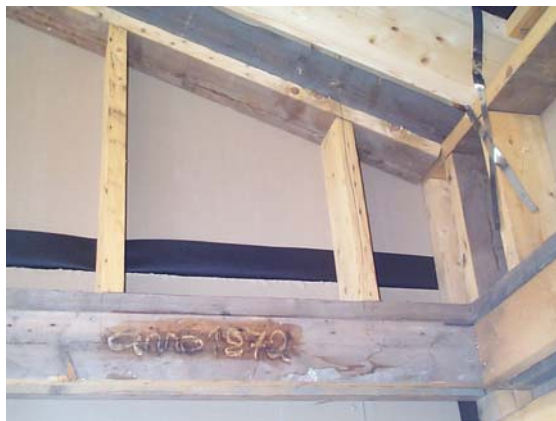
Bildet viser gjenbruk av trebjelker i Gjenbrukshuset I Trondheim. (Foto: Wiger)
