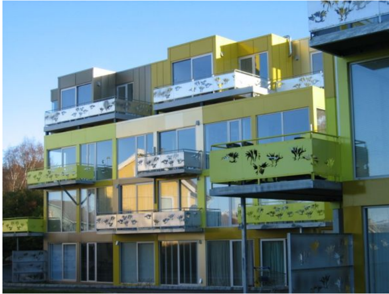
Bildet viser nybygde boliger av utrangerte boligbrakker fra offshoresektoren er satt sammen på nye måte. Boligene er bygget på Buøy i Stavanger og tegnet av arkitektkontoret Helen & Hard. Foto: Leland.
