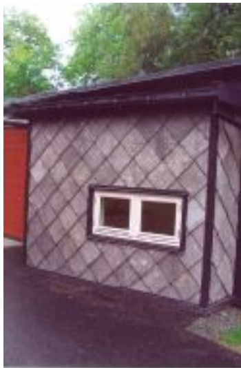
Ombruk av skifer fra tak- til veggkledning i Vinkelkroken barnehage, Trondheim. Foto: Leland
