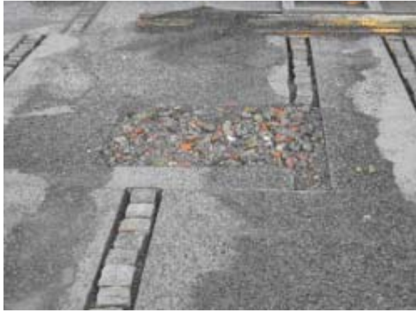
Bildet er fra anlegging av en plass i Pilestredet Park, Oslo. Her ombrukes gatestein, og det benyttes brukt knust tegl og betong som fyllmasse (foto: Leland)
