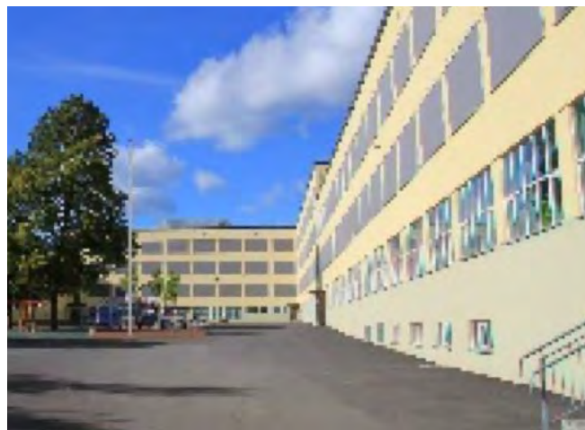
Sinsen skole ETTER, etterisolering, der man har fått mindre strømforbruk og dermed lavere driftskostnader. Foto: Vidar Iversen
