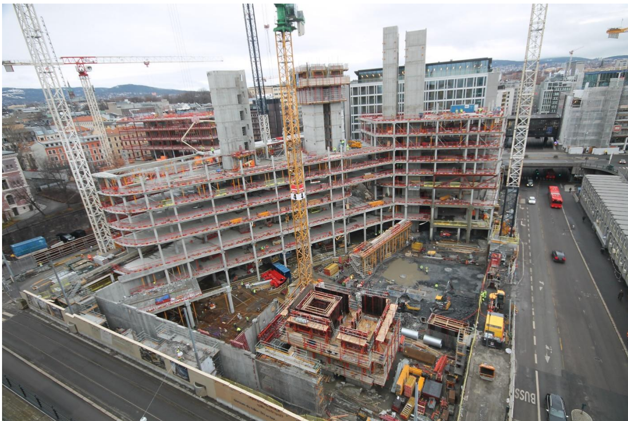
Figur 5. Under byggingen av VIA i Ruseløkkveien 26 i Oslo kommune. Foto: Rambøll Norge, november 2019. Sertifisert BREEAM-NOR Excellent.
