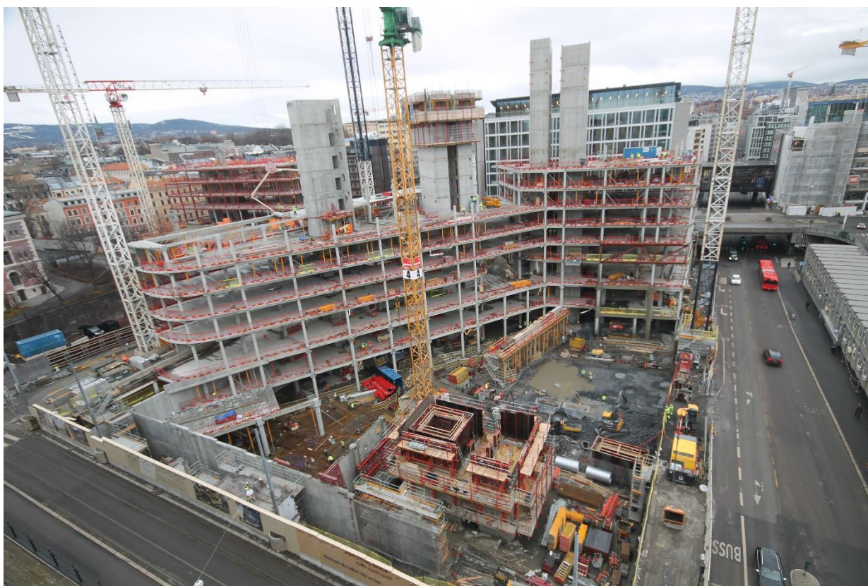
Figur 4. Under byggingen av VIA i Ruseløkkveien 26 i Oslo kommune. Foto: Rambøll Norge, november 2019. Sertifisert BREEAM-NOR Excellent.
