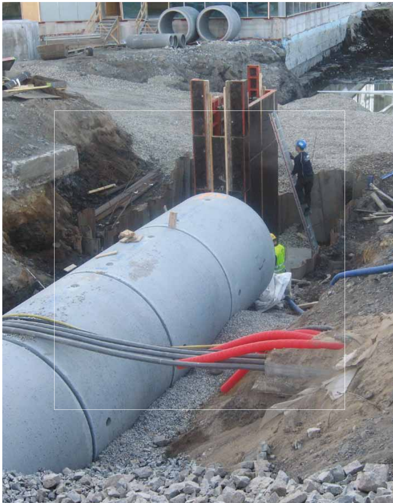
Foto: Norconsult, 3.Ledningsanlegg Hovinbekken, Midtgaardsormen, Oslo
